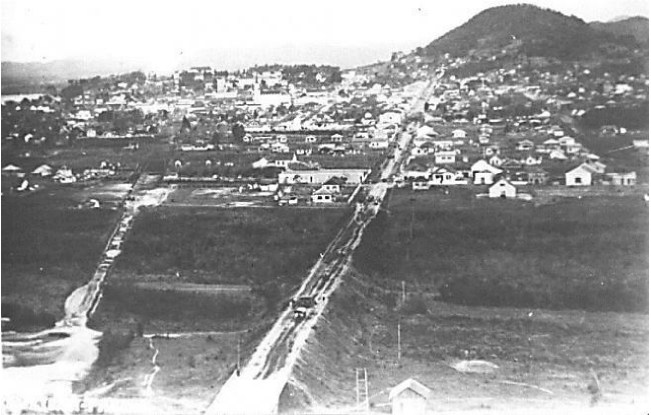
Figura 02: Construções ao longo do aterro/Ponte Manoel Ribas
